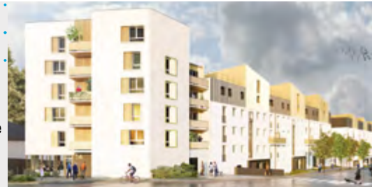
▲ Réhabilitation de la résidence La Coconnière à Laval
