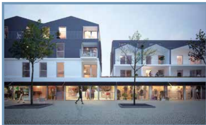
- 8 appartements résidence du Le Parvis du Louvernay à Louverné
