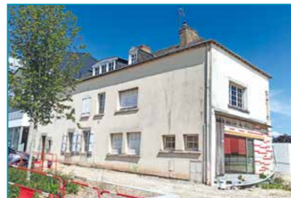
/// Le Parvis du Louvernay (Îlot 3) Réhabilitation de 2 maisons de ville pour créer 5 appartements Architecte : Kraft Architectes
