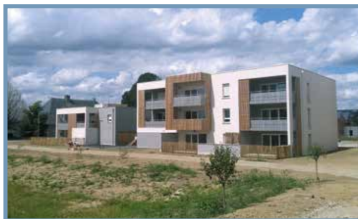
- 1 appartement résidence Mazarine à Mayenne
