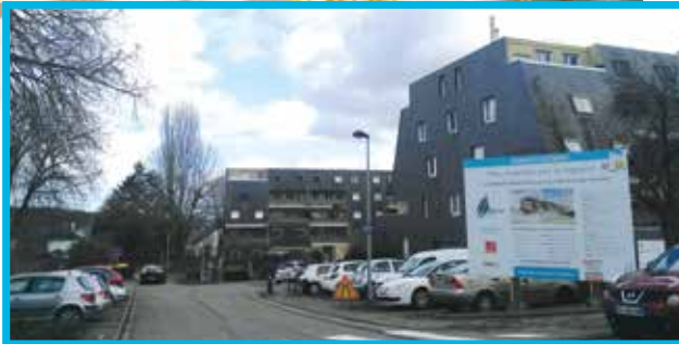
Résidence Francis Lévesque, projet de réhabilitation.
